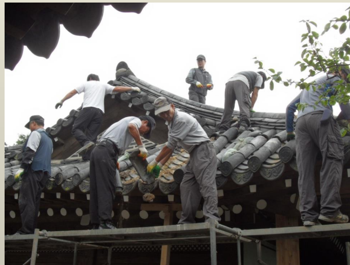
기와 해제 작업(기와 부분보수작업)
