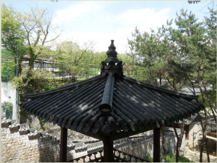
지붕 기와 보수 완료
