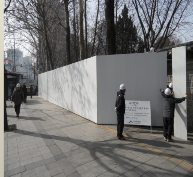
안전 가림막 설치
