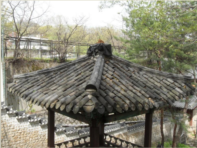
지붕 기와 보수 전(숫기와 이완 및 교란)
