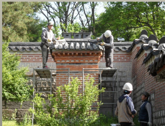
굴뚝 기와 보수(이완 및 파손기와 교체)
