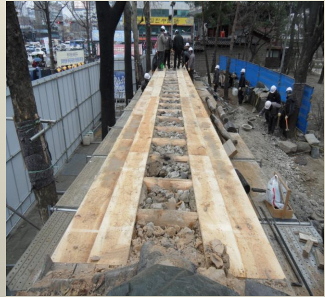
연목 개판 설치 완료
