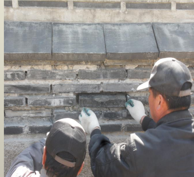
파손된 전벽돌 교체
