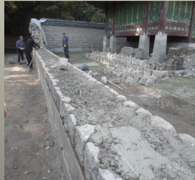
사고석 쌓기 및 속채움
